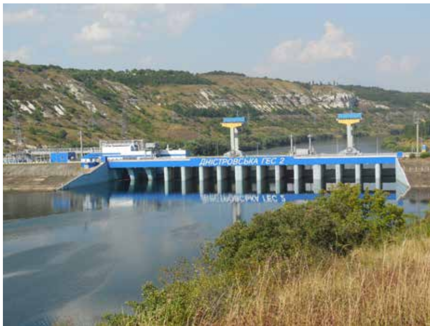
Рис. 1. ГЭС-2 Днестровского гидроэнергокомплекса
