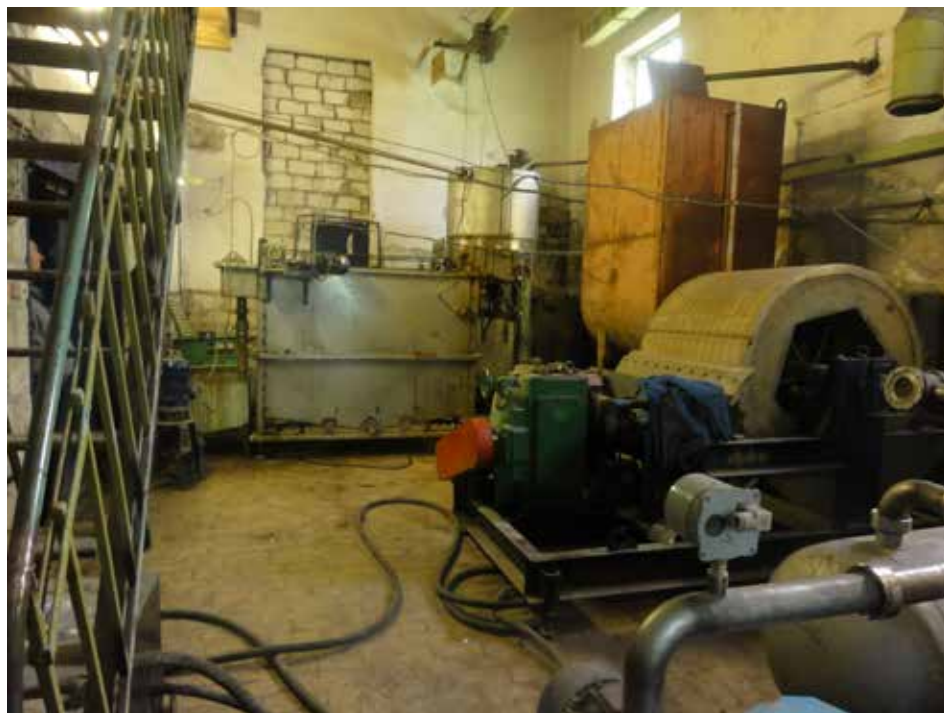
Рис. 2. Общий вид основного технологического оборудования на производственном участке по переработке, обезвреживанию и утилизации ферроцианидных осадков виноделия на предприятии ВТЕСТ (бывш. завод «Алиментармаш»)
